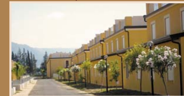
Pizzo Beach Club, фаза II — начальная стадия строительства, инвестиционный проект
