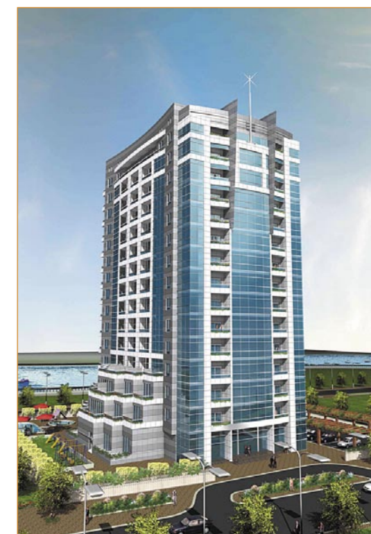
Новый дом Marina Diamond Three станет украшением прибрежного поселка Dubai Marina.
